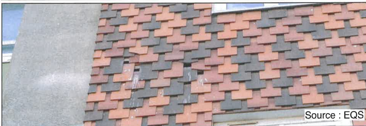
FIGURE 11 : LOGES À ÉTOURNEAUX SUR LE BÂTIMENT A
